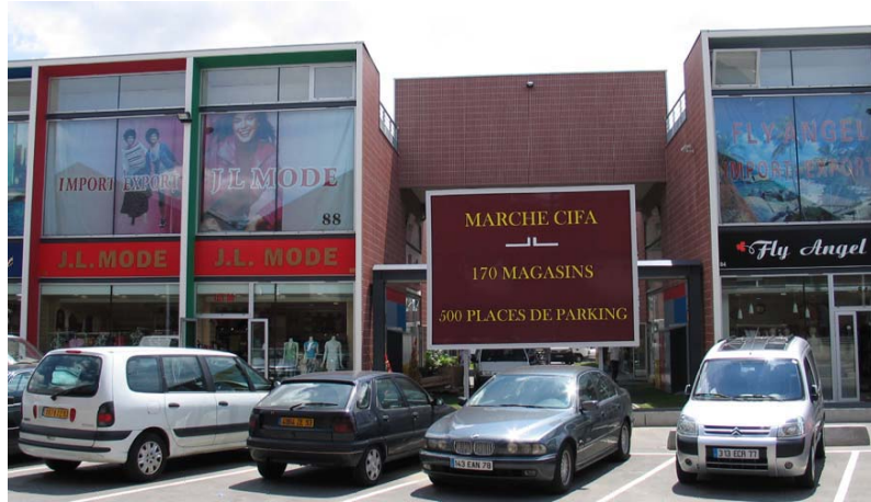
Marché CIFA - première tranche réalisée sur la rue Saint-Gobain
