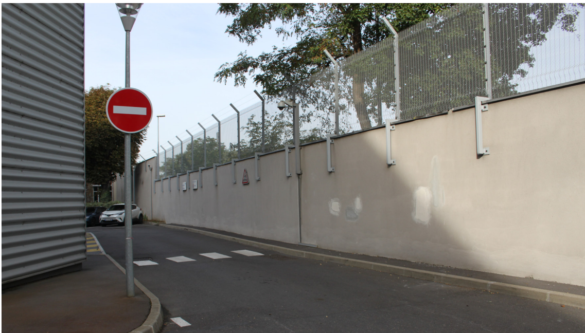
Digital Realty (Interxion) data center, rue du Rateau in La Courneuve (93). Source : L'Institut Paris Region, 2021.
