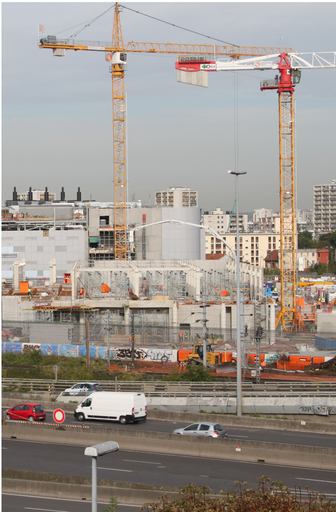
The Digital Realty (Interxion) PAR 8-11 data center under construction in La Courneuve. Source : L'Institut Paris Region, 2021.
