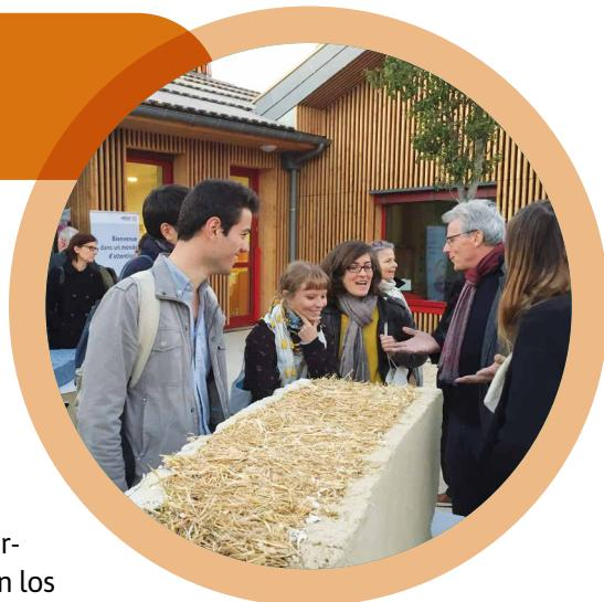
La estructura de carga del colegio únicamente la conforman fardos de paja revestida, procedentes de un cultivo de cereales biológico en Seine-et-Marne. / Marc Barra, ARB Ile-de-France.
