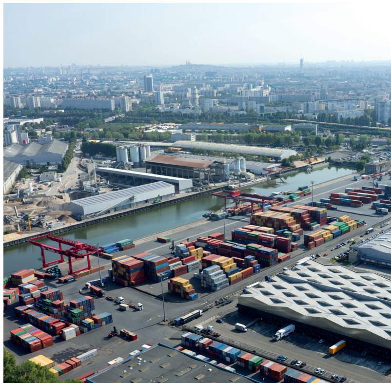
热讷维耶港 © 塞纳河港口群
