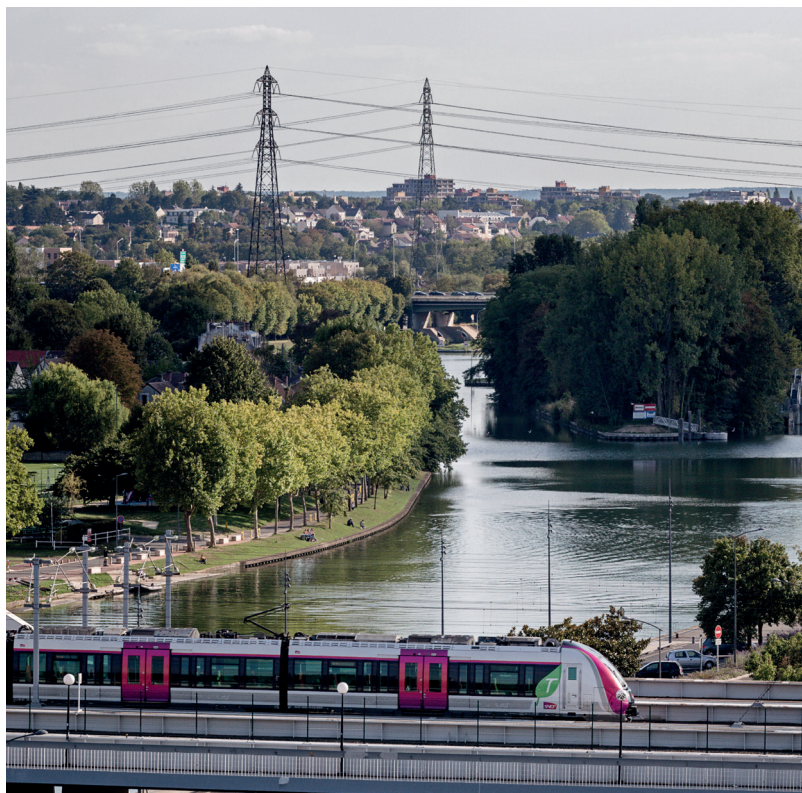
瓦兹河上的铁路桥 © 皮埃尔·伊夫·布鲁诺 (Pierre-Yves Brunaud) - 巴黎大区研究院
