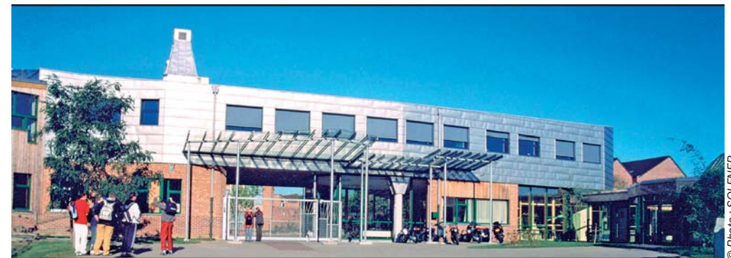
Illustration 57 : Cheminée de ventilation naturelle assistée – Lycée de Caudry, Calais (59). Architectes : QUATR'A Architectes associés (X. Bouffard, J.L. Leclercq).
