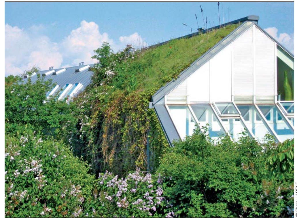
Illustration 71 : Toitures végétalisées, Stuttgart (Allemagne) – Wohnen 2000 IGA. 1993.
