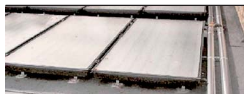
Illustration 59 : Les capteurs solaires thermiques en toiture. Usage optimisé du solaire thermique pour une maison et sa piscine Avon (77).
