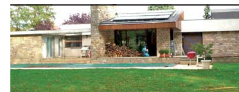
Illustration 60 : Intégration architecturale des capteurs solaires. Usage optimisé du solaire thermique pour une maison et sa piscine, Avon (77).
