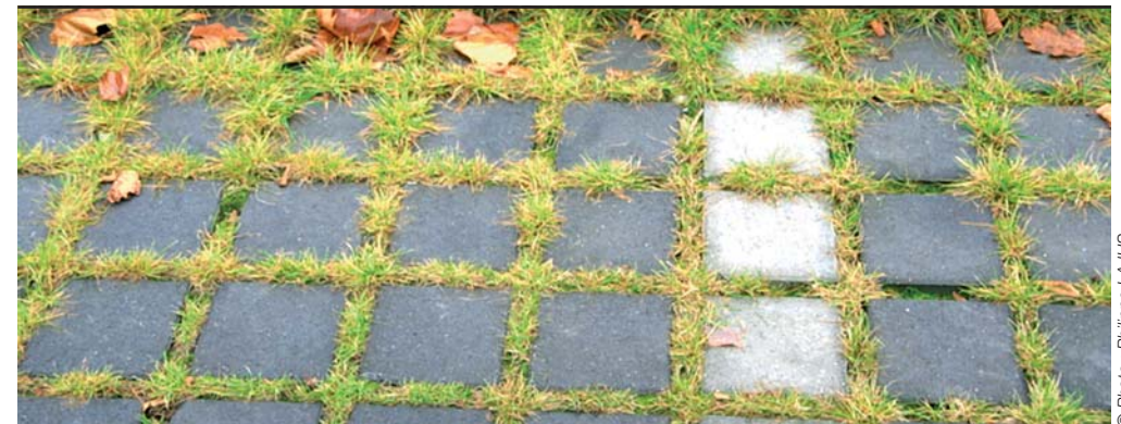
Illustration 19 : Stationnement engazonné, détail – Quartier Vauban, Fribourg (Allemagne).
