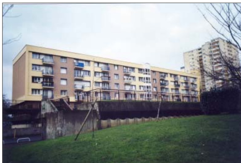
Le bâtiment dans le quartier de la Noue.
