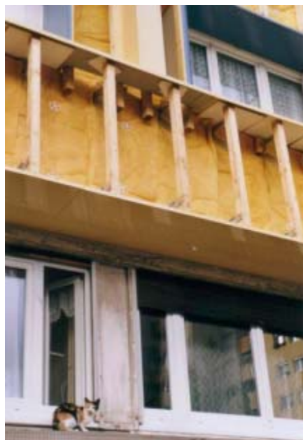
Façade durant les travaux.
