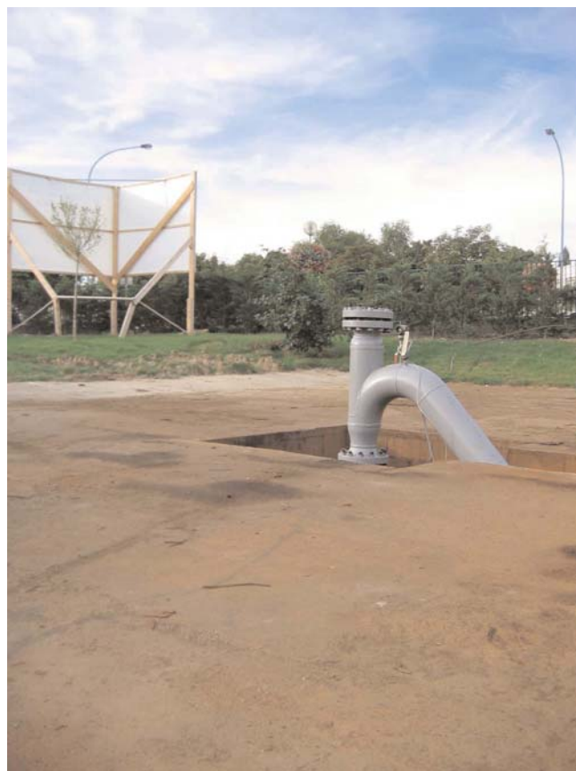
Tête de puits après travaux.
