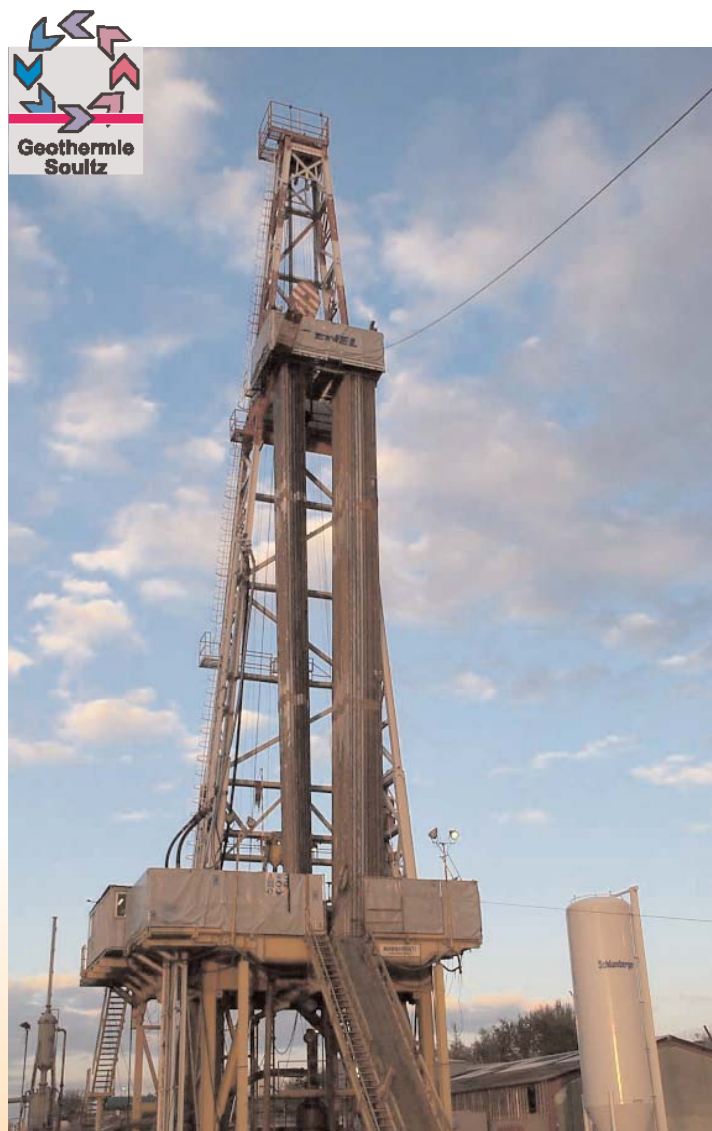
Mât de forage pour un puits à 5 000 m de profondeur.
