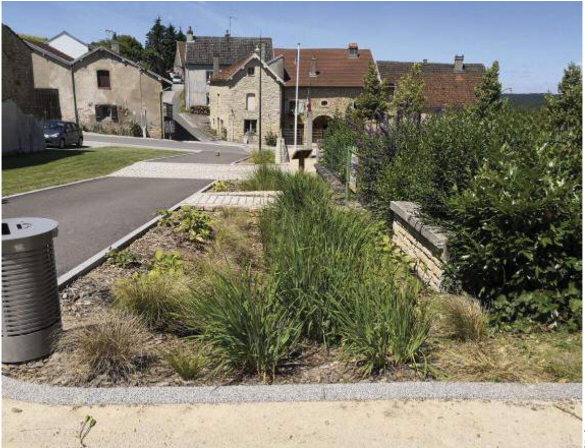
Noue végétalisée sur le Square Madiba
