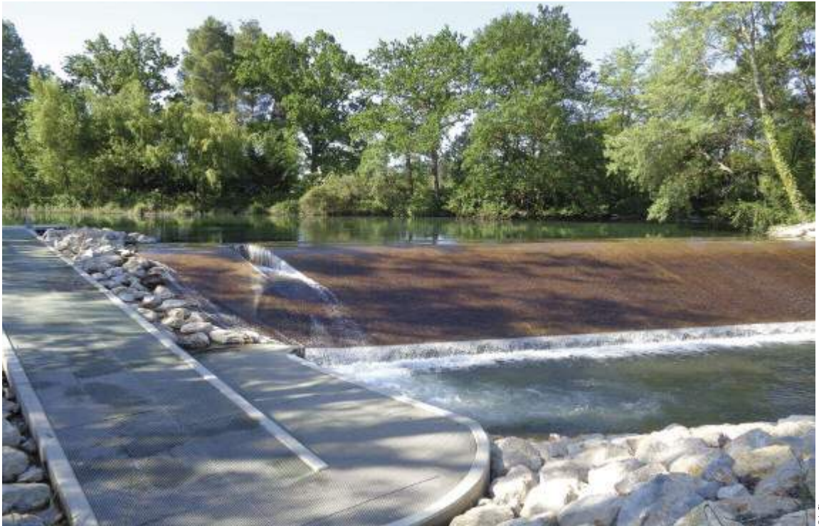
Seuil et passe à poissons de la Croupière
