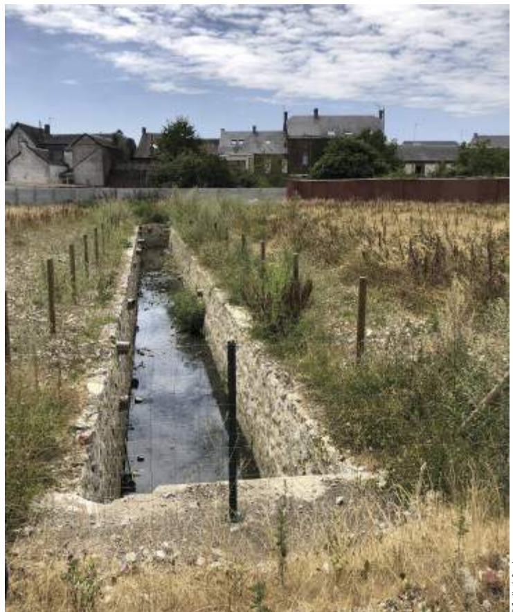
Réouverture du ruisseau des Besaces sur la friche Miroux
