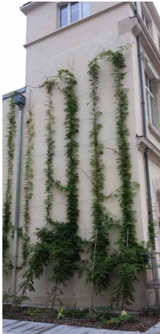
Les murs aveugles et pignons peuvent accueillir des plantes grimpantes qui offriront protection contre les intempéries, rafraîchissement de l'air et accueil de la petite faune. © M. Barra
