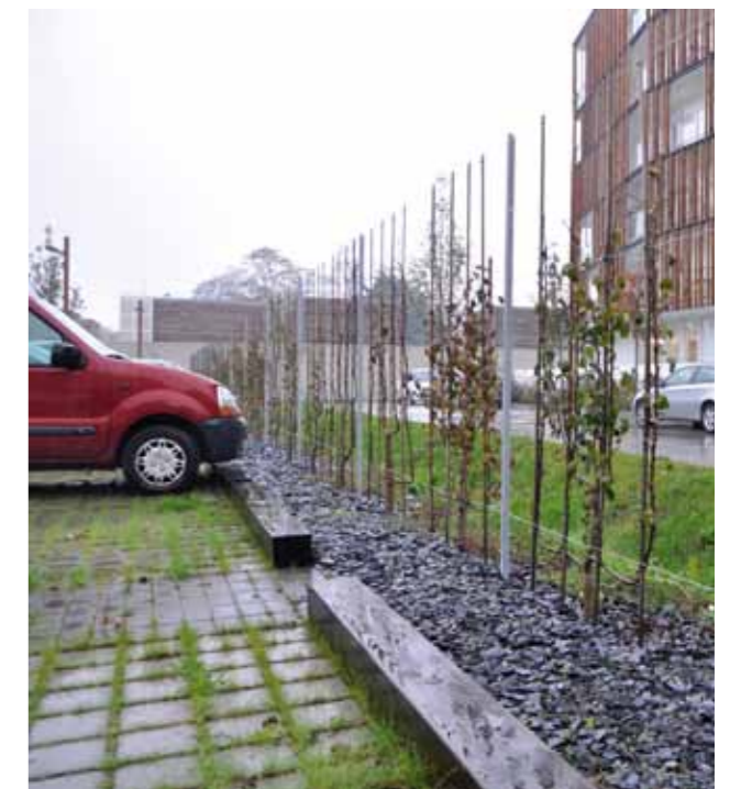
Parking, cheminement, accès pompiers, autant d'espaces qu'on peut aménager sans imperméabiliser. © G. Lecuir
