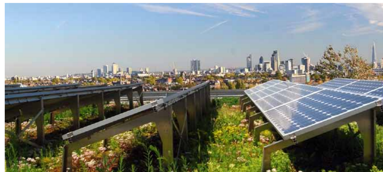
Associer énergie solaire et végétalisation offre un gain mutuel : la végétation rafraîchit les panneaux et augmente leur productivité, tandis que ceux-ci offrent de l'ombre et une diversité d'habitats à la flore. © 2015 Green Roofers Ltd
