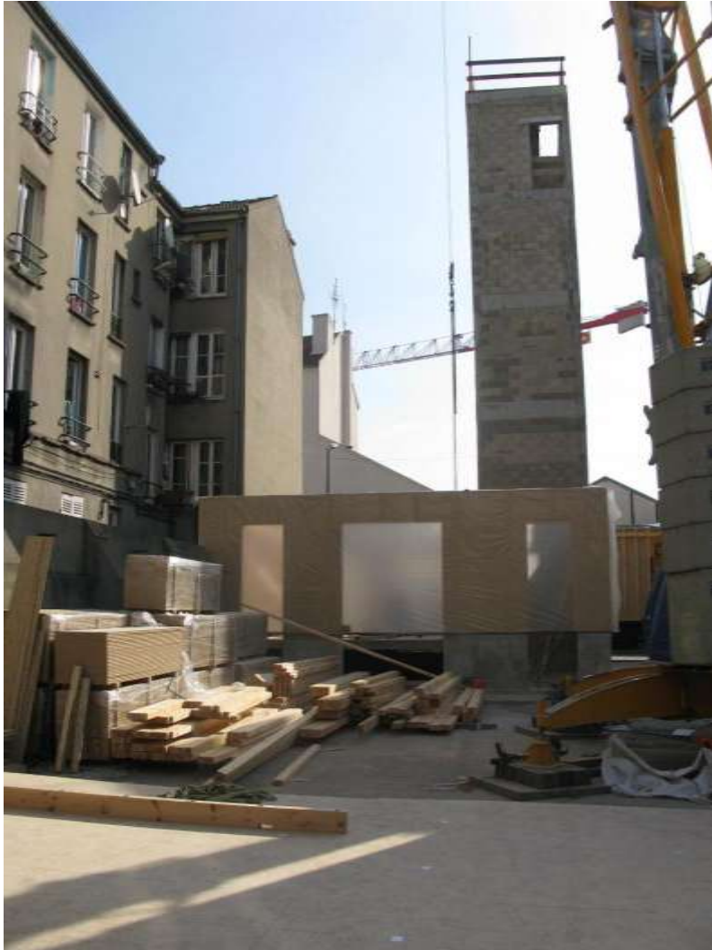
Plancher bois, enveloppe ossature bois
